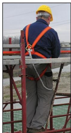
6- Indossare i dispositivi di protezione individuale di collegamento: imbracatura completa (EN 361), cordino (EN355) di lunghezza m 1,40 completo di assorbitore di energia (corsa m 0,50 a completa apertura) e moschettoni di fissaggio (ved. fig.10).
